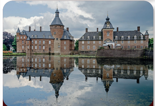
Abb. 4: Burg Anholt, Westfassade
