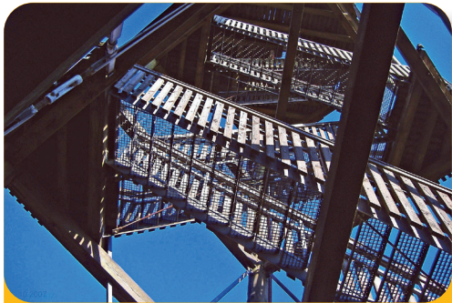
Abb. 2: Aussichtsturm: Treppe aus Gitterrosten
