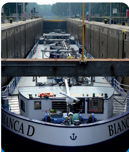
Abb. 1: Schleuse Gleesen bei Emsbüren, Dortmund-Ems-Kanal
