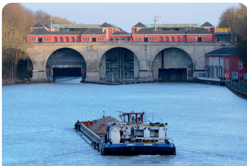
Abb. 2: Mittellandkanal, Schleuse Anderten bei Hannover
