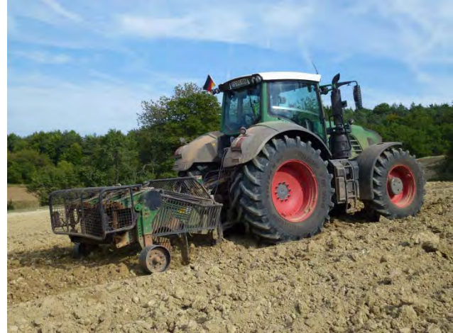
Abbildung 12: Rekultivierung des Arbeitsstreifens durch Spatenlockerung
