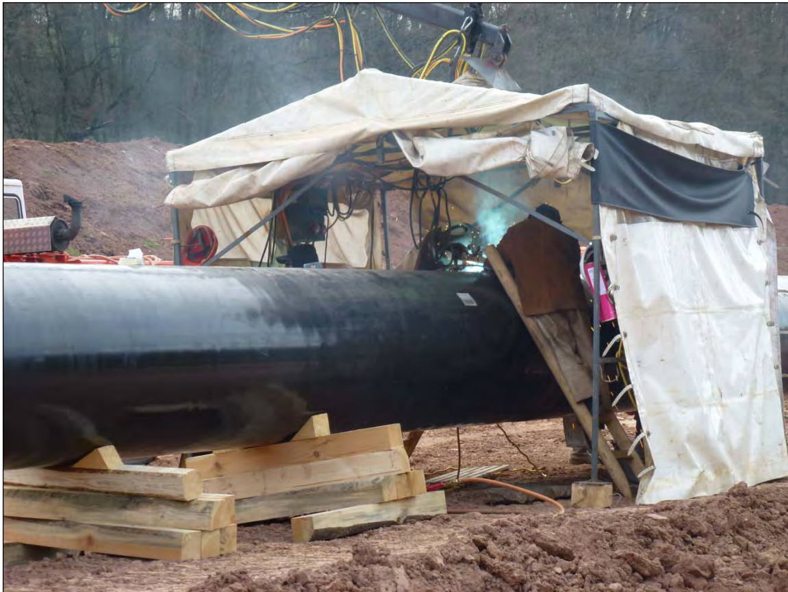
Abbildung 8: Verschweißen der Rohre zum Rohrstrang
