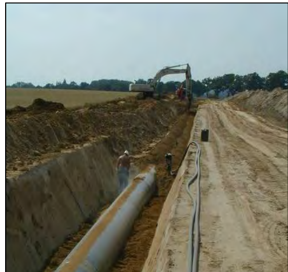
Abbildung 11: Verfüllen des Rohrgrabens
