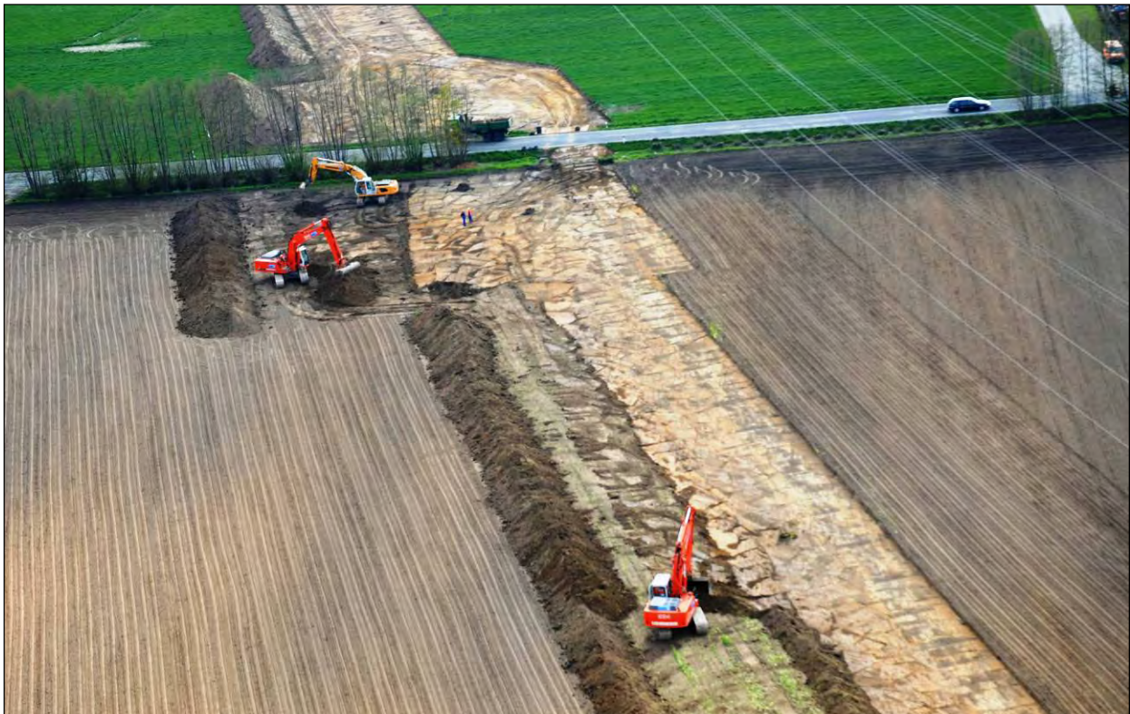
Abbildung 6: Abschieben und Lagern des Mutterbodens (Oberboden)
