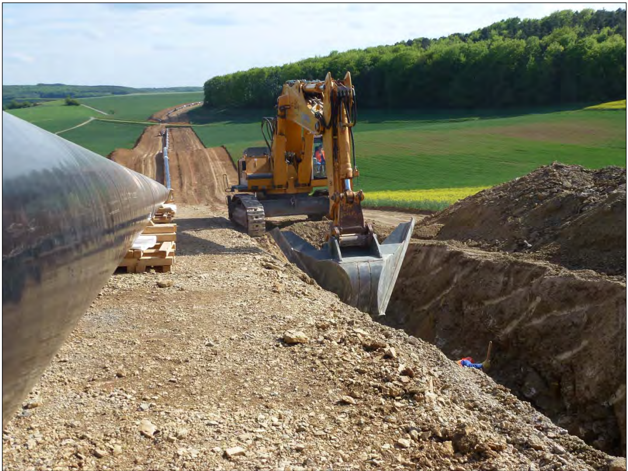
Abbildung 9: Aushub des Rohrgrabens
