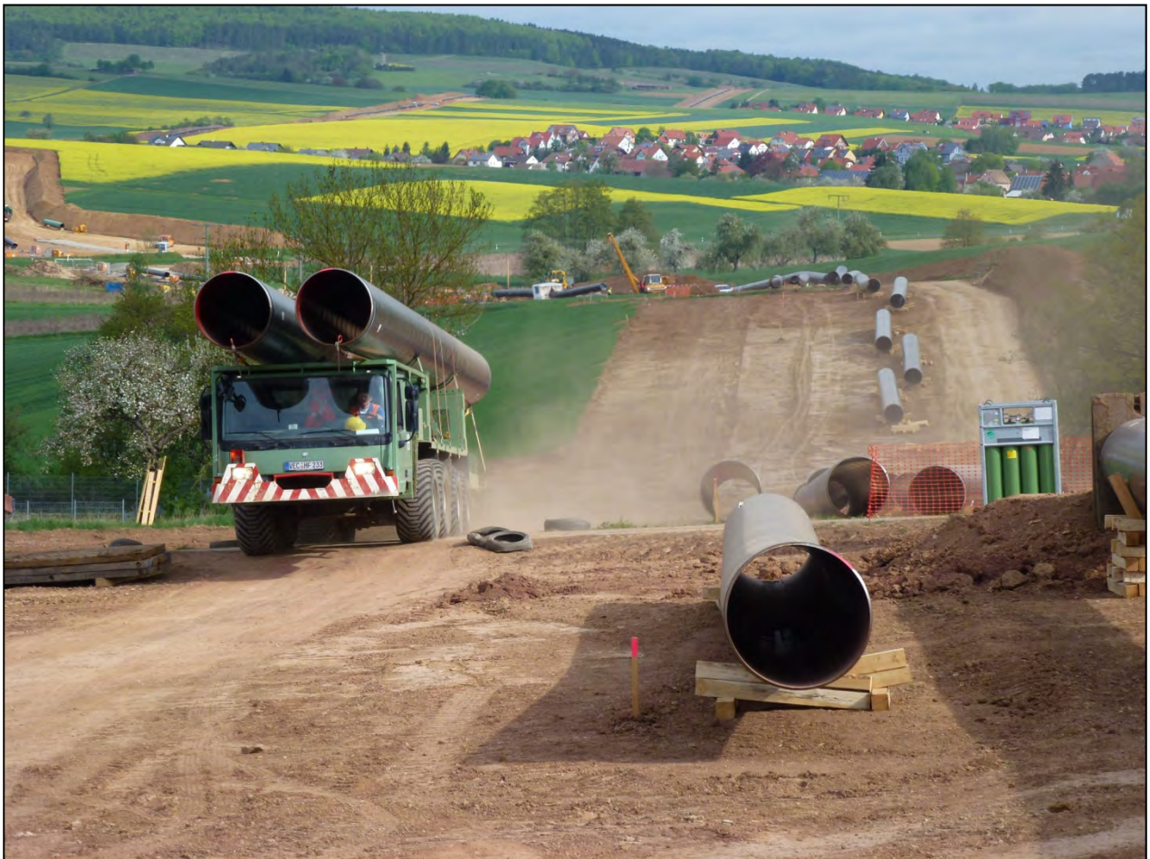
Abbildung 7: Rohrausfuhr im Arbeitsstreifen
