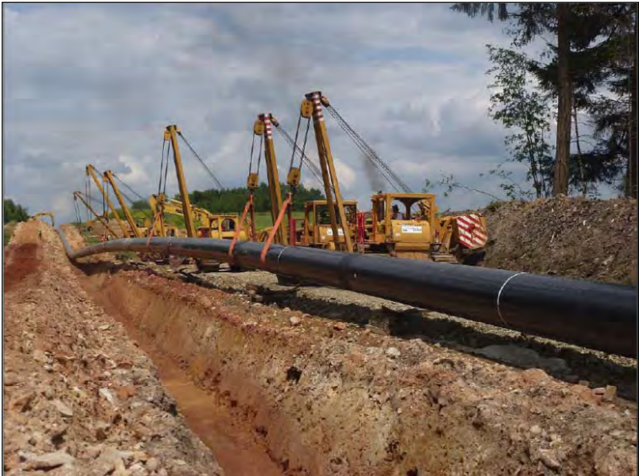
Abbildung 10: Absenken des Rohrstranges
