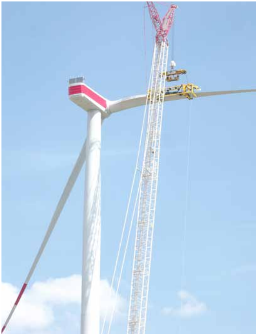
Montage der Rotorblätter
